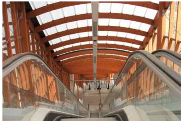
Potenza, Scala Mobile Ponte attrezzato, particolare interno
