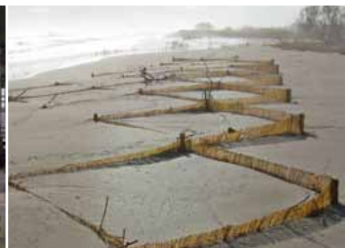
CODRA Mediterranea, difesa dall'erosione e recupero delle coste
